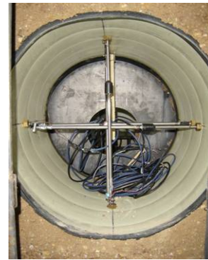
Figura 14 Deformada de la tubería el final del ensayo
